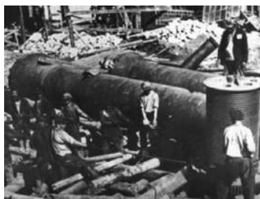
На строительстве химкомбината
