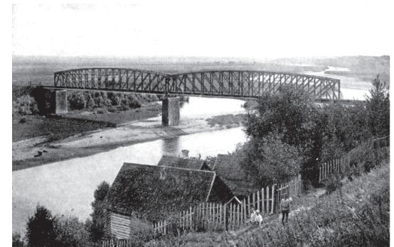
Железнодорожный мост через реку Жиздра до войны [2]
